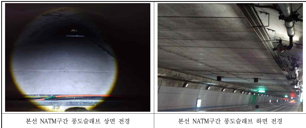
【사진 3.3.9】 NATM구간 풍도슬래브 전경
