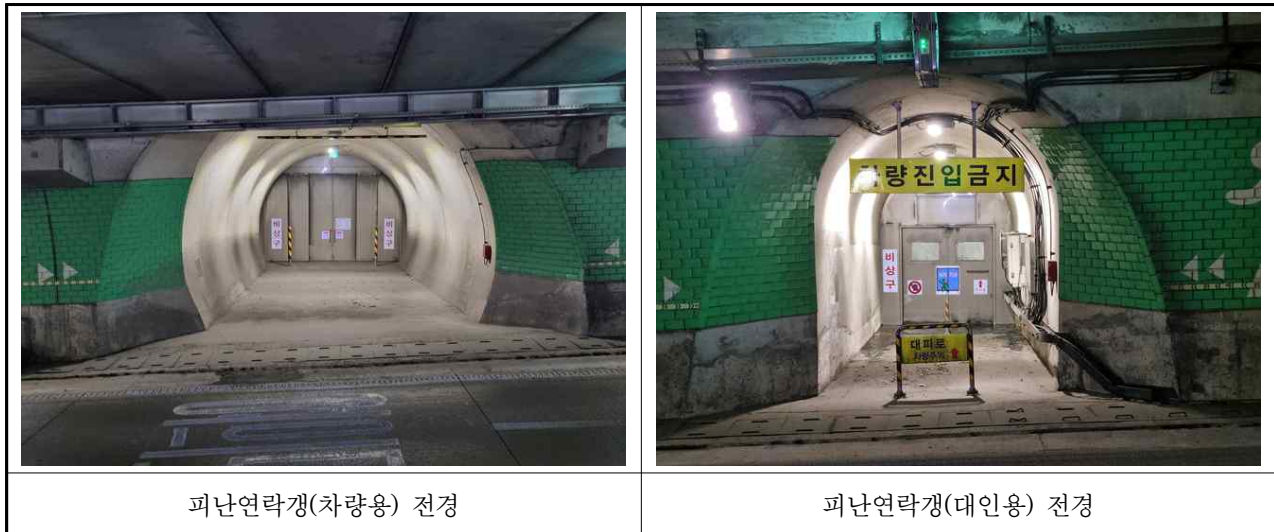
【사진 3.3.37】 피난연락갱 전경
