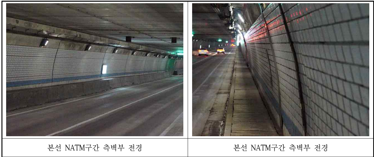
【사진 3.3.7】 NATM구간 측벽부 전경
