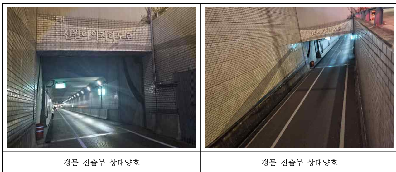
【사진 3.3.36】갯문 손상현황
